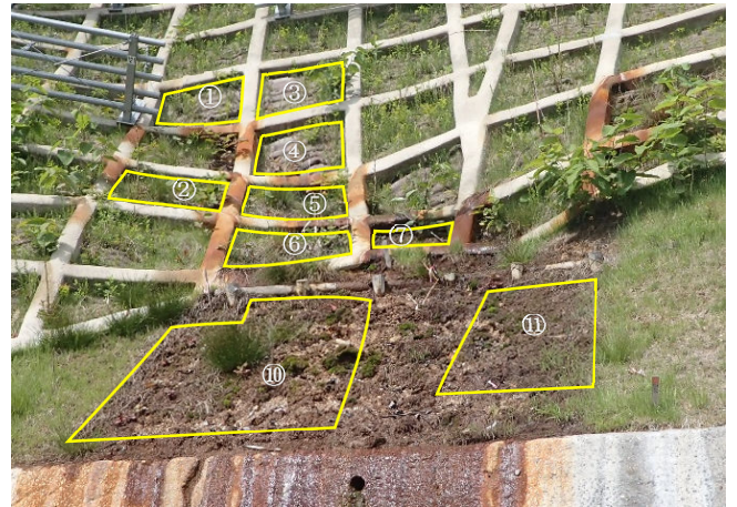
a. 施工前（2018 年 5 月 30 日）[写真-2]
