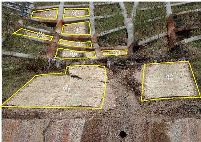
b. 施工後（2018 年 10 月 18 日）[写真- 3]
