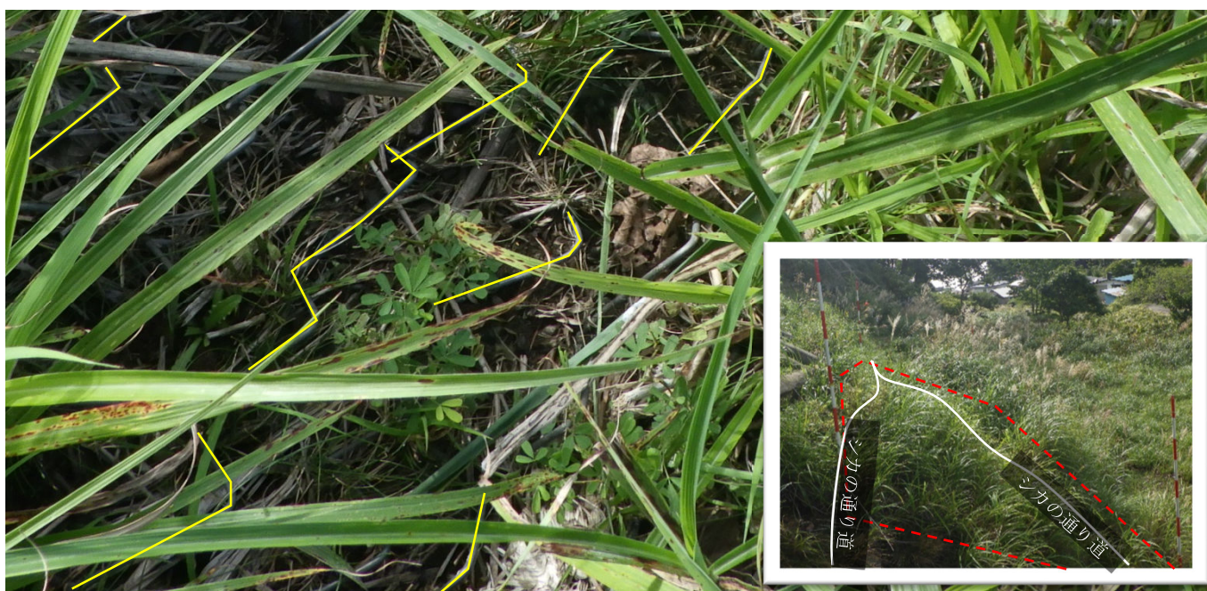
グリーンスラッガー+三角金網施工地内のシカの通り道の拡大写真（写真-R7-2 黄線は露出している金網の鉄線）
