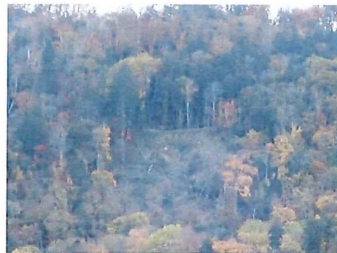
沼ノ沢の崩壊地 2023.10.18
