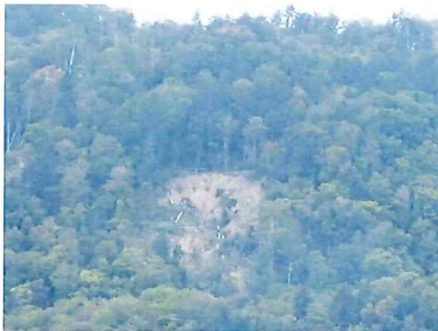
沼ノ沢の崩壊地 2022.09.16
