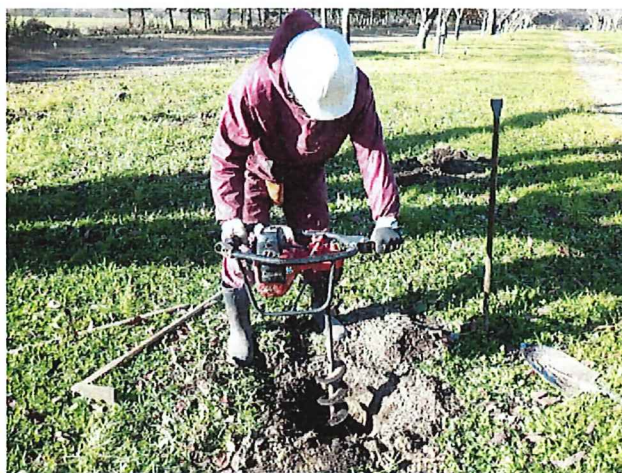
アースオーガーによる掘削
