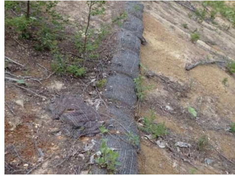
土嚢筋工 高丘 8 2022.05.19
