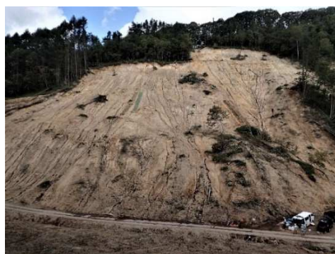
幌内 EBA 施工地（施工直後） 2019.09.24
