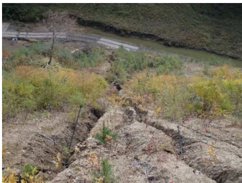
①ガリー（縦浸食段階） EBA 施工地外 2022.10.18
