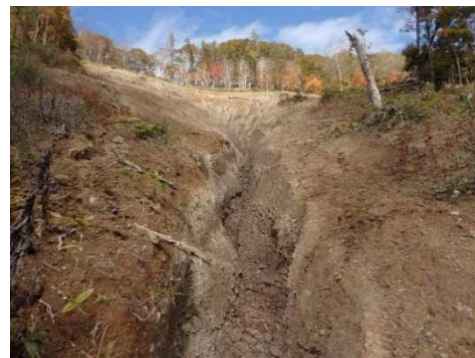
②ガリー（横浸食段階） EBA 施工地外 2022.10.18
