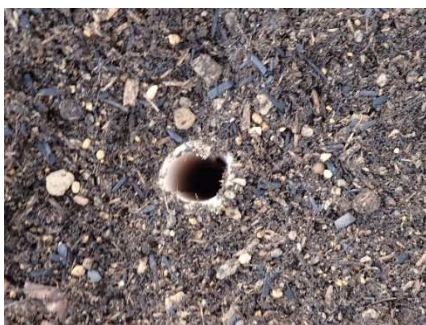
割竹縦穴式土壌改良法の混合土の充填後
