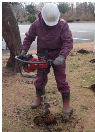
アースオーガによる縦穴掘り
