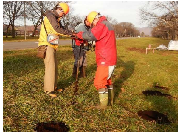
アースオーガによる縦穴の掘削（金田正弘氏撮影）
