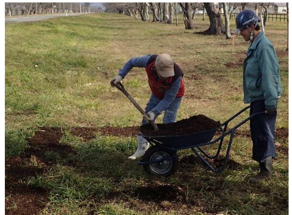
混合土の投入
