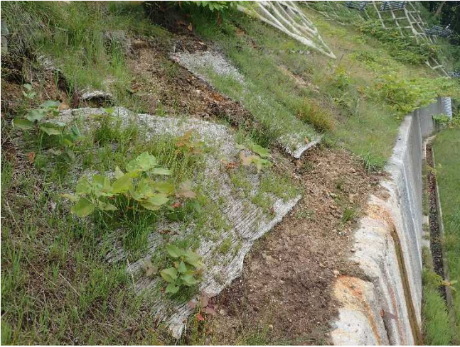
植生シート（フルポストロー：F S S F - II）の緑化状況 (2019.07.17)
