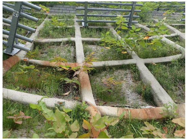
現場打法枠工内の緑化状況 (2019.07.17)
