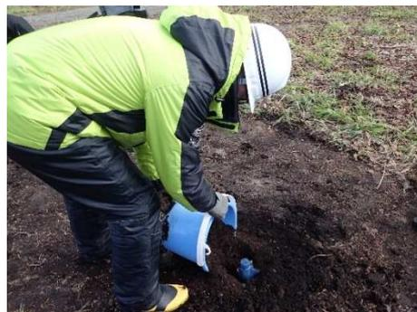
掘削・割竹挿入後の「混合ハイブリット」充填状況
