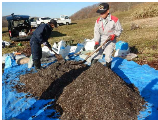
充填材攪拌状況 (金田正弘氏撮影 2021.11.20)
