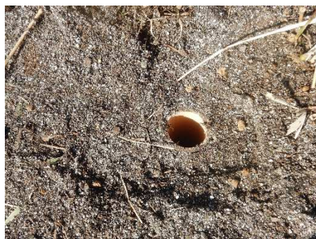
割竹縦穴への充填材の投入状況 (金田正弘氏撮影 2021.11.20)
