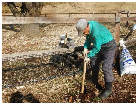
割竹挿入状況 (金田正弘氏撮影 2021.11.20)
