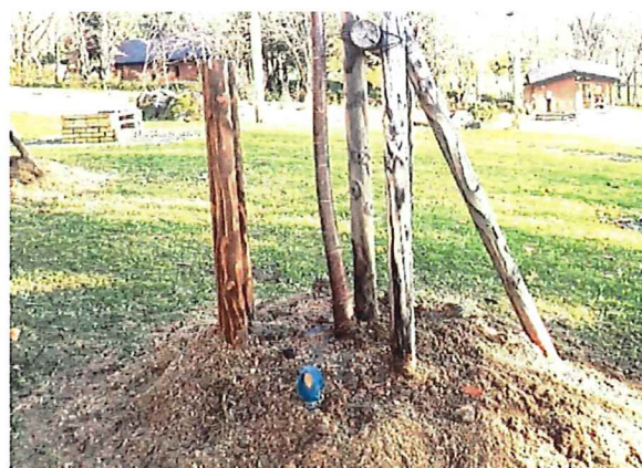
防雪杭の設置 (青色は割竹縦穴) 2019.10.28
