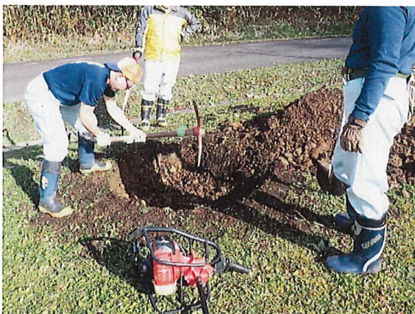
植え穴の掘削状況
