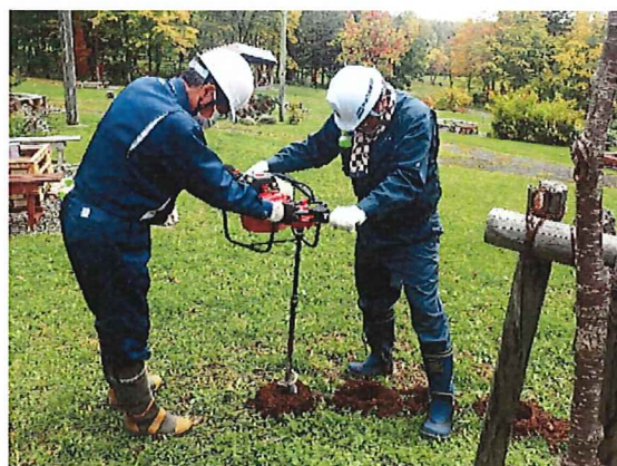
アースオーガによる縦穴掘削 2021.10.14
