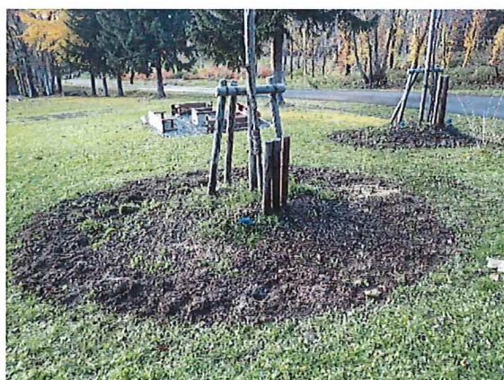
縦穴式土壌改良法施工状況 2020.10.26
