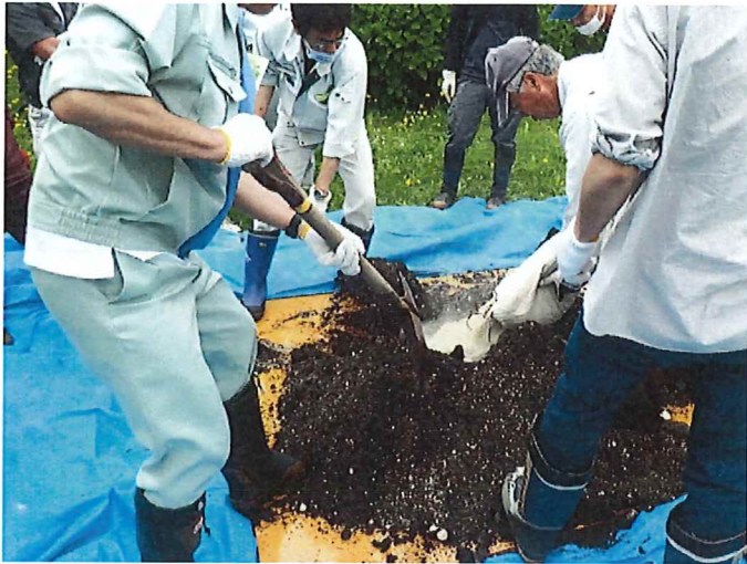
土壤改良材作成
