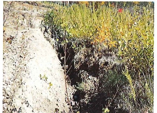
幌内（シカ柵あり）EBA 施工地横のガリー 2023.10.26
