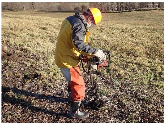
アースオーガによる縦穴掘削 2022.11.17
