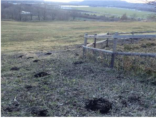
縦穴掘削状況
