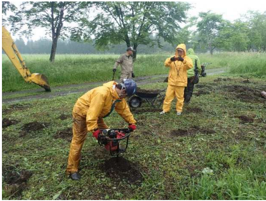
アースオーガーによる縦穴の掘削
