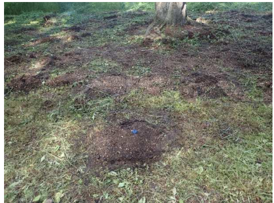
割竹縦穴式・縦穴式土壤改良法の施工状況
