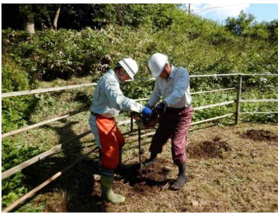
アースオーガによる縦穴掘削（金田紘幸氏撮影）
