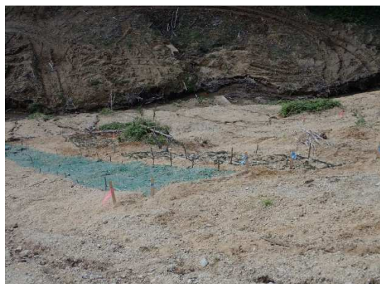
幌内 施工直後 (斜面上部から撮影) MPA (左) EBA (右) 2019.09.24
