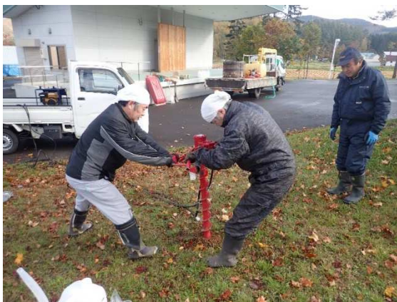
油圧式のアースオーガでの縦穴の掘削
