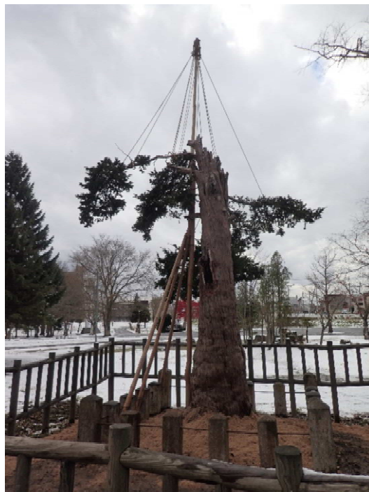
今回完成した雪吊り
