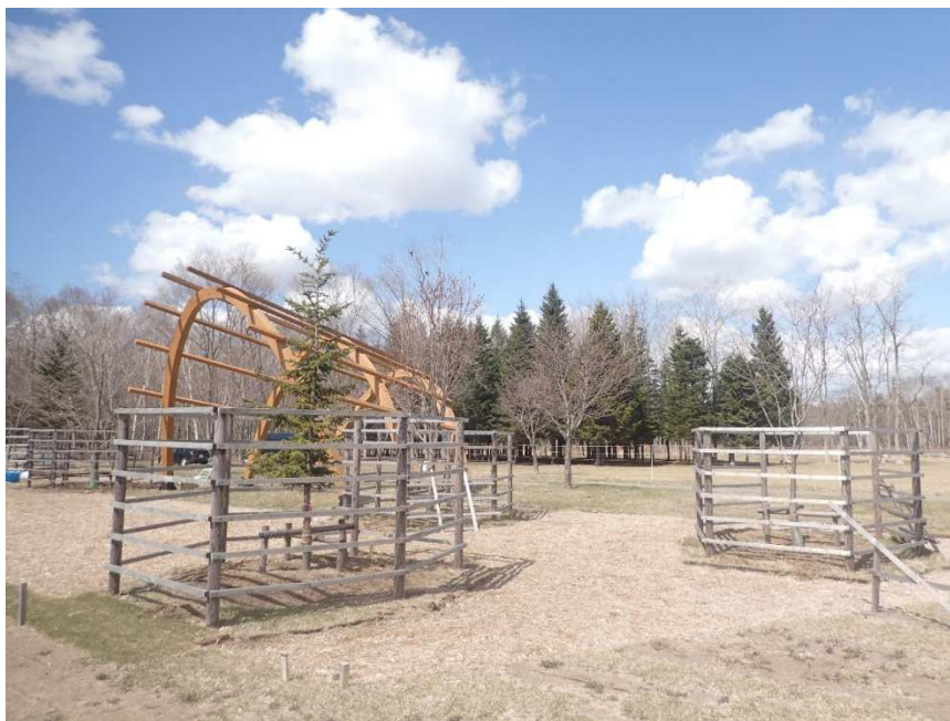
保育作業完了した一部対象木
