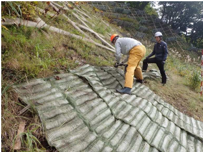
アルカリ資材「グリーンスラッガー」の敷設
