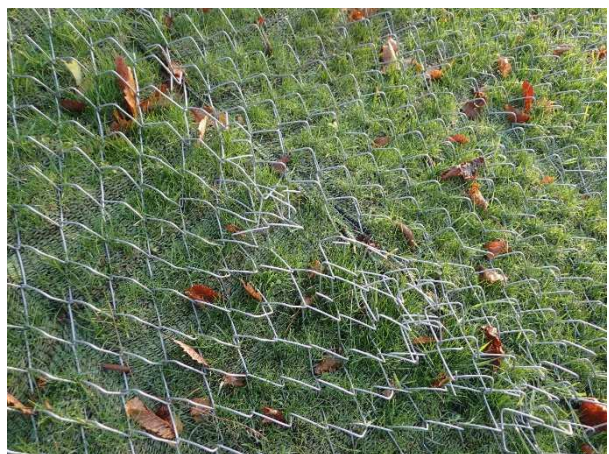
三角金網の端部のほつれ（シカ侵入の形跡）
